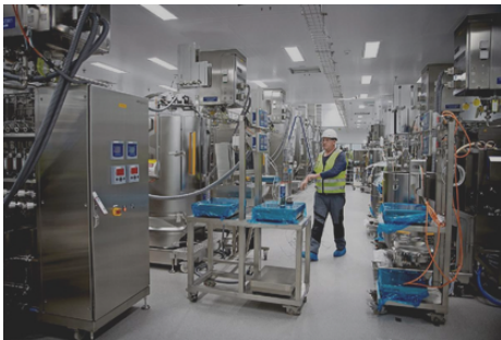
Chantier d'une des unités de production des vaccins Moderna contre le Covid-19, sur le site du groupe Lonza à Viège, début octobre.
